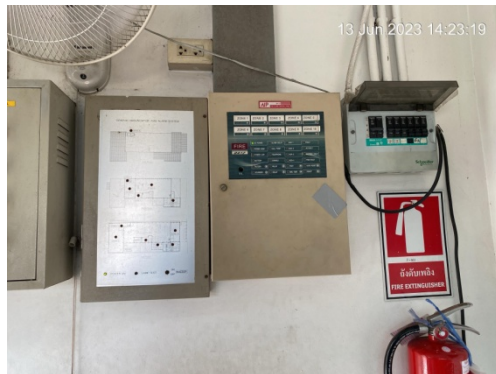
แผงควบคุมระบบสัญญาณแจ้งเหตุฉุกเฉิน
