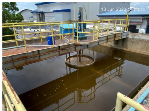
รูปที่ 3-3 ระบบบำบัดน้ำเสีย
