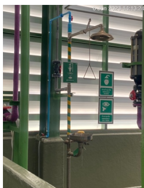
รูปที่ 3-23 ที่ล้างตาฉุกเฉิน
